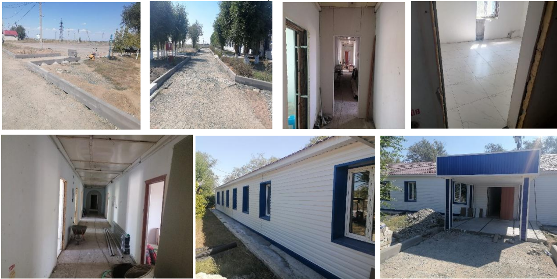
Ремонт здания офиса №1 Площадки 22:
